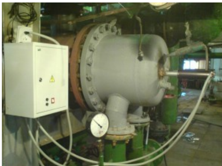
Рис. 2. Установка ультразвукового генератора на водогрейном котле
