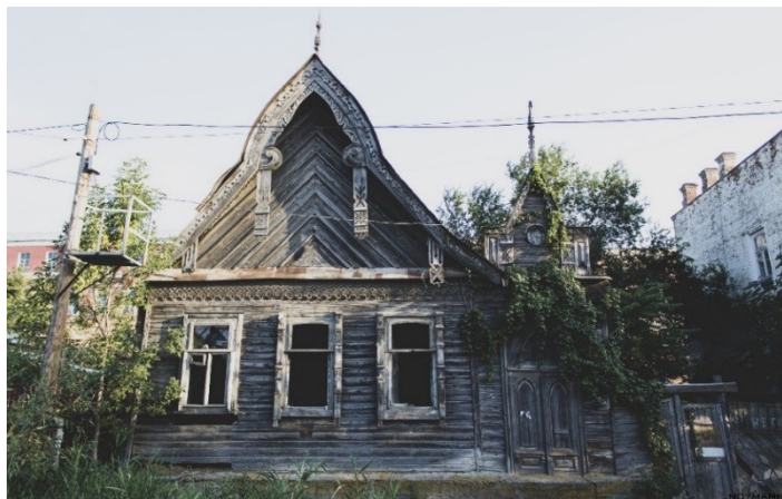
Рис. 2. Прорезная резьба на фасаде жилого дома
