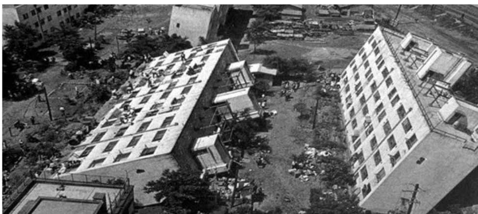
Рис. 3. Опрокидывание железобетонных зданий при землетрясении в г. Ниагата (Япония) 16 июня 1964 г.
