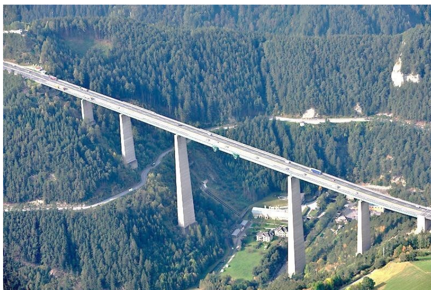
Рис. 1. Балочный мост Breyer, Германия [12]
