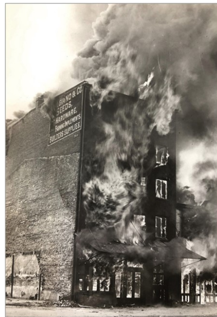
Рис. 2. Крупномасштабное огневое испытание здания (Ingberg fire test in Washington, D.C., 1928)
