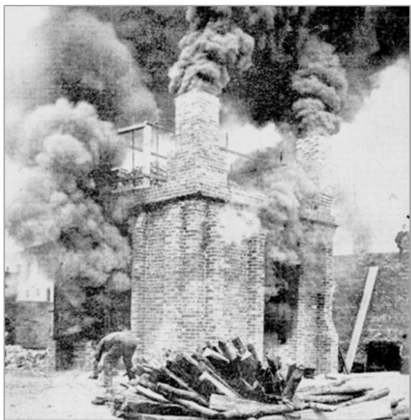
Рис. 1. Первые испытания конструкций в огневой печи (Stewart and Woolson, 1902, USA)
