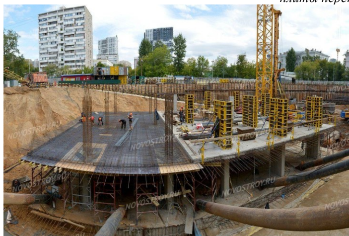
Рис. 3. Устройство рабочих швов бетонирования на отметке верха плиты перекрытия (стык плита-колонна)
