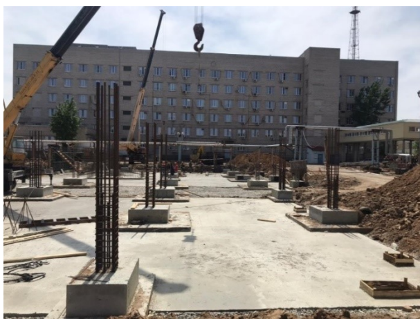
Рис. 1. Устройство рабочих швов бетонирования на отметке верха ростверка
