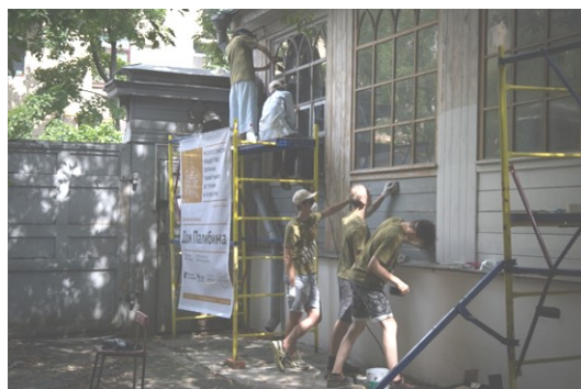
Рис. 1. Работы по восстановлению фасада дома коллежского советника А. Г. Палибина
