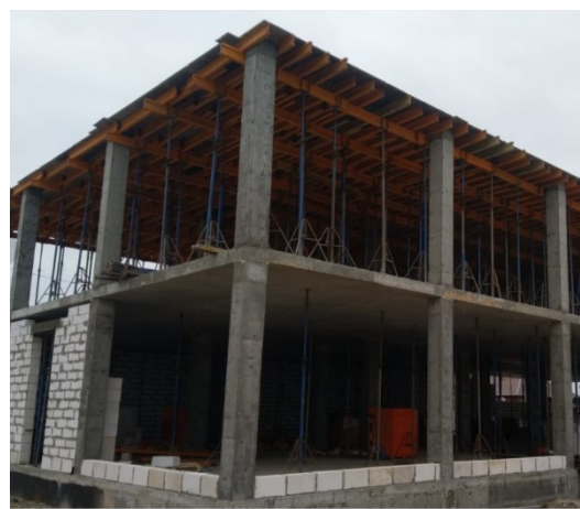
Рис. 2. Устройство рабочих швов бетонирования на отметке низа плиты перекрытия
